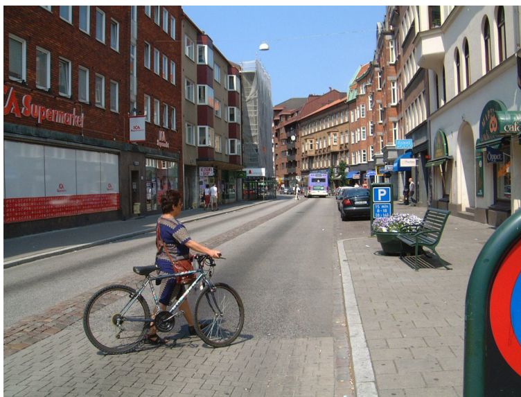
Mynd 10 Hellulögð miðlína og bílastæði auka áhrif þrengingar í Malmö.
